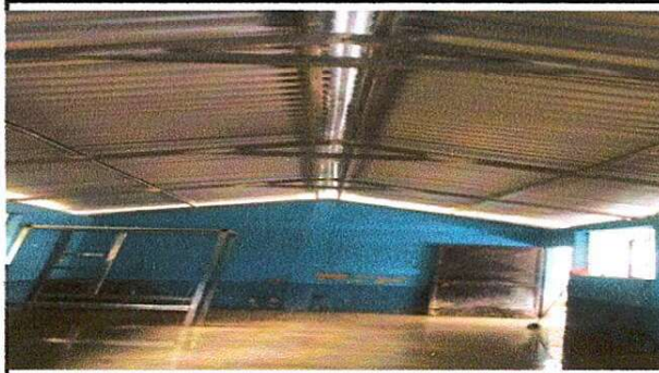
Foto 2: cubierta de lámina finalizado.
