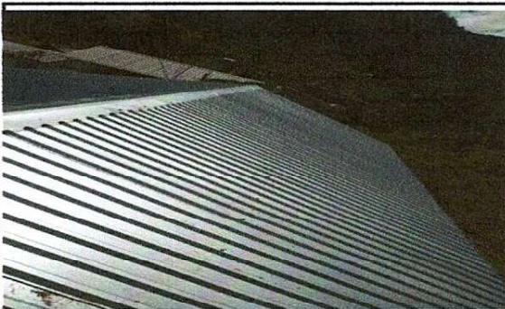
Foto 3: cambio de cubierta de lamina calibre 26.
