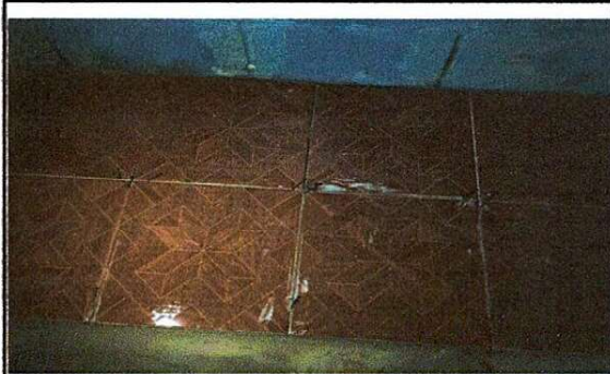
Foto1: piso ceramico en proceso total
